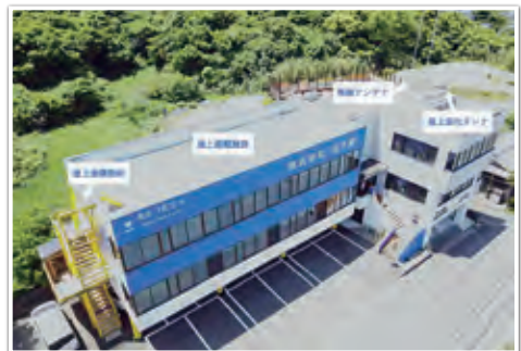
屋上へ避難できる外部階段を設置し、標高を明記した自社ビル
