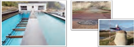
図2 耐震化の有無による被害有無の状況 (左：浄水場、右：マンホール浮上)
