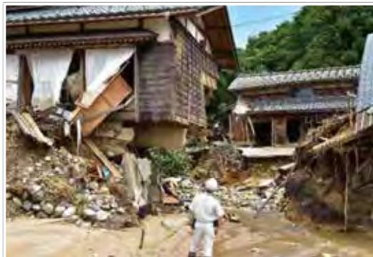
村上市小岩地区の土石流被害（写真提供：村上市）
