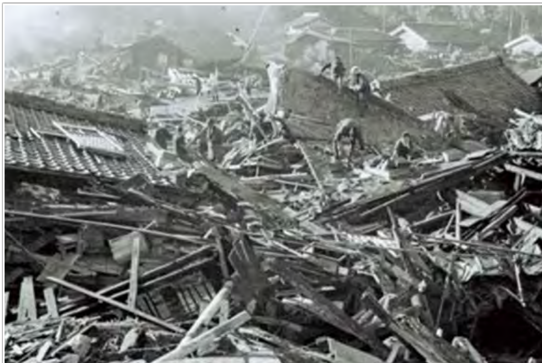
東南海地震の被害の様子（三重県尾鷲市）
