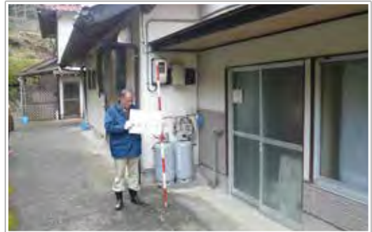
今福地区自主防災会員止水栓調査
