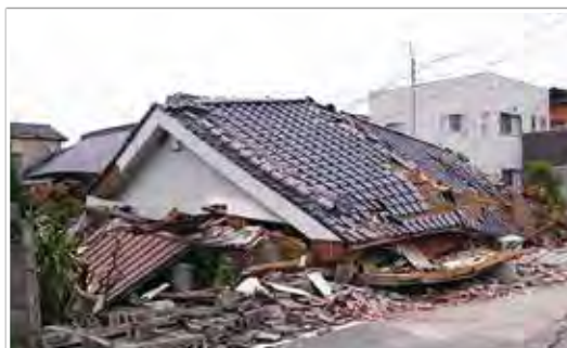
平成28年熊本地震 被害状況
