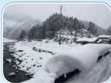
兵庫県香美町長須橋の欄干
