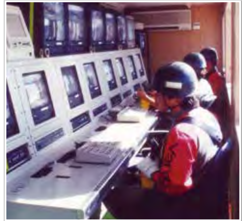
写真-4 無人化施工の遠隔操作作業状況 (1994年4月11日)(松井宗廣氏撮影)
