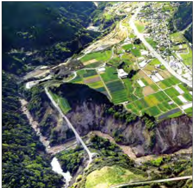
図2 熊本地震によって発生した斜面崩壊の様子(アサヒ・グラフ2016年4月版より引用)
