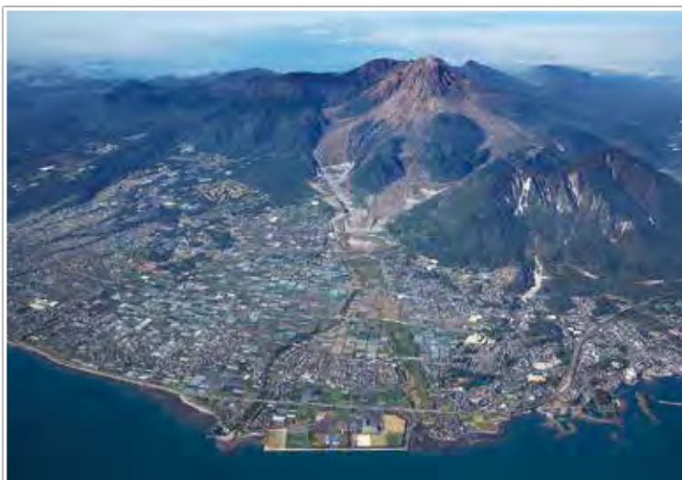
写真-6 雲仙普賢岳と水無川流域の正面写真(2019年11月21日)(雲仙復興事務所撮影)
