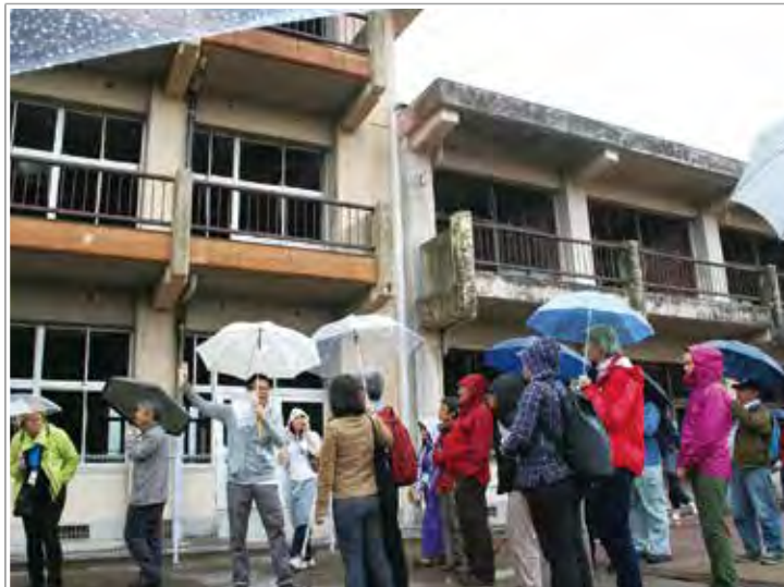
写真-5 ジオパーク国際会議のツアー (旧大野木場小学校被災校舎、2012年5月14日) (島原半島ジオパーク事務局撮影)
