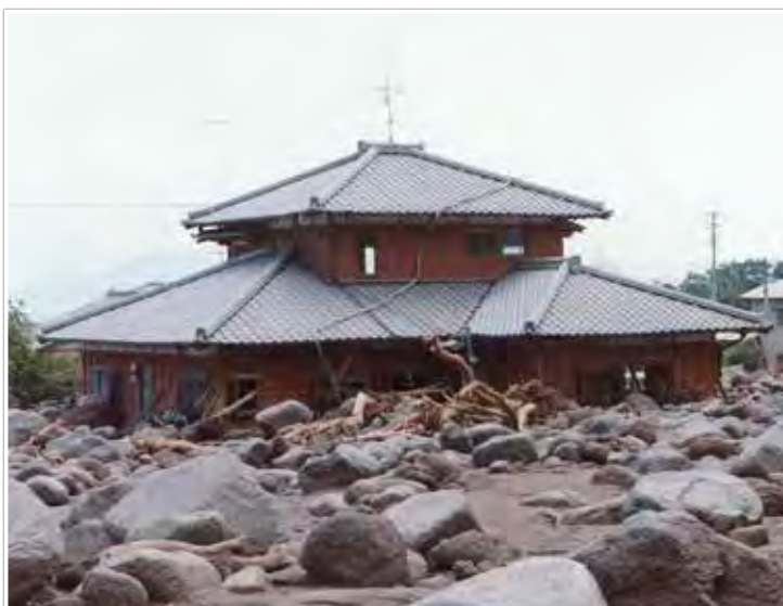
写真-2 土石流に埋まった家屋(安中地区、1993年4月30日)(杉本伸一氏撮影)
