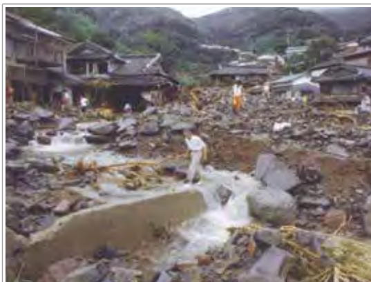
崖崩れが起こった国道34号線長崎市芒塚付近
