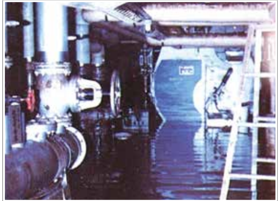
写真4 長崎市民病院の地下電気室の浸水状況 (提供;長崎市)
