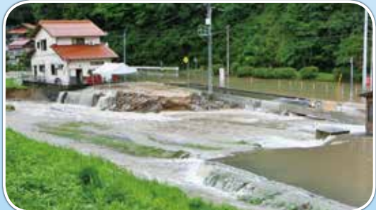
江の川が決壊し住宅地に浸水（島根県江津市）
