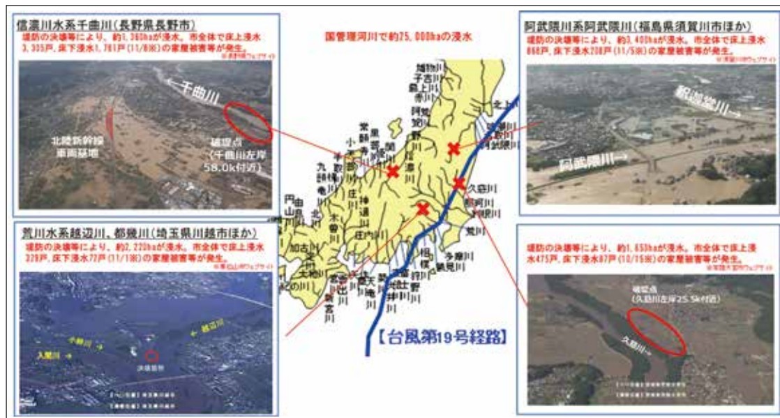
図 - 1 令和元年東日本台風（台風第19号）における被害
