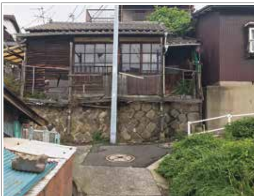
山王地域の空き家
