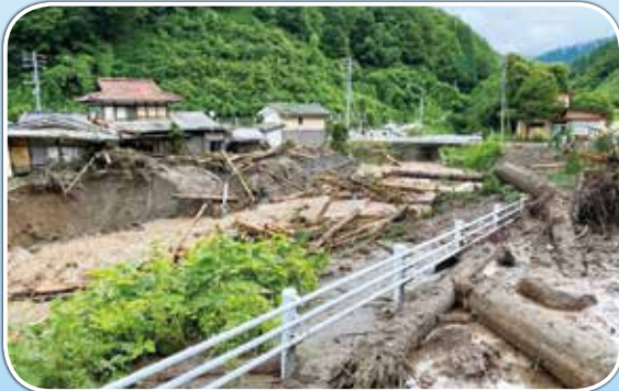
生井川を越えた土石流により倒壊した住居（岐阜県高山市岩井町）
