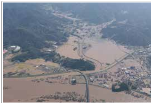
宮城県丸森町上空から見た浸水状況 (国土交通省水管理・国土保全局提供)
