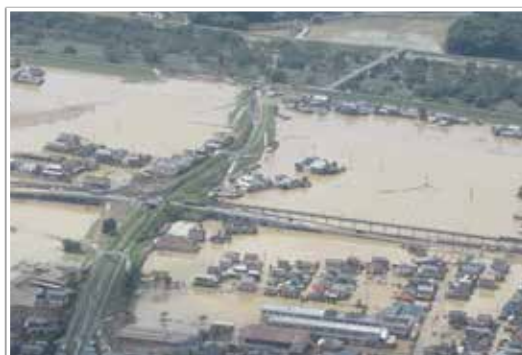
岡山県倉敷市真備町の浸水状況
