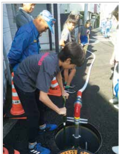
スタンドパイプの訓練
