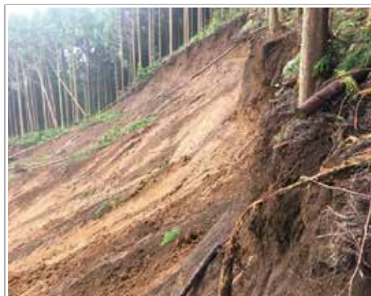
写真 1 源頭部の状況（10月14日12時頃）
