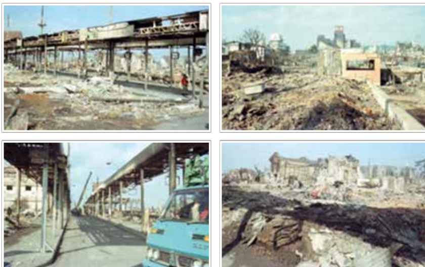
写真1 酒田大火後の被災状況 (酒田市提供)
