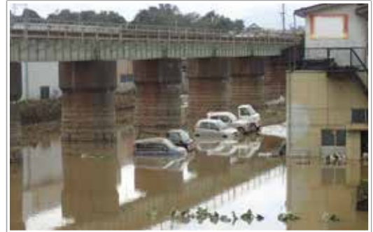
写真4 福島県郡山市の浸水被害
