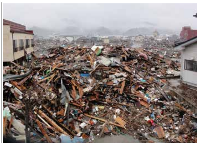
津波による被害
