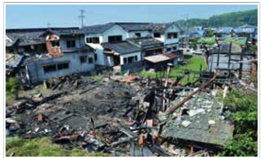
アルミ工場の水蒸気爆発による爆風被害(写真提供:総社市)
