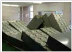
生徒靴ロッカーの転倒
