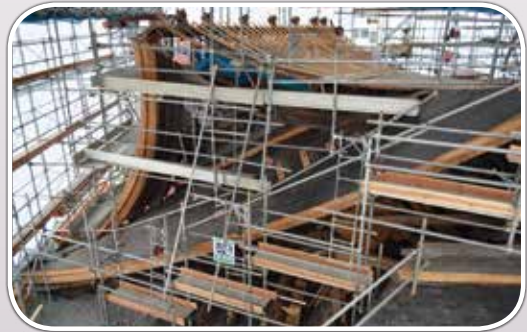
補修工事中の阿蘇神社
