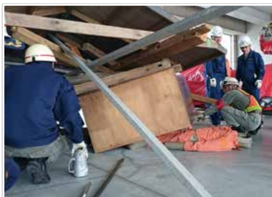
倒壊家屋からの救助訓練
