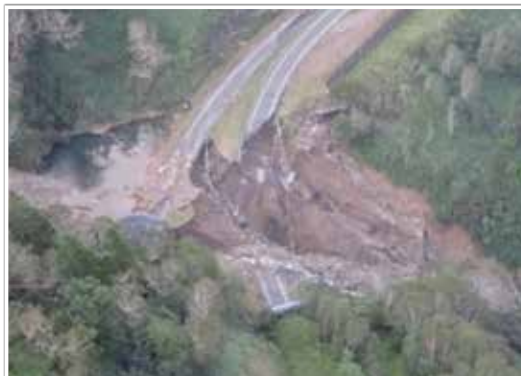
国道274号 日勝峠8号目付近 道路洗掘（清水町）
