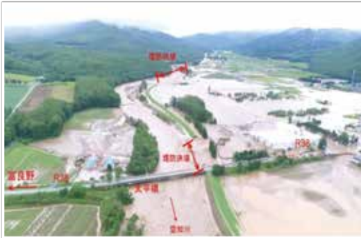
石狩川水系 空知川堤防決壊（南富良野町 幾寅地区）
