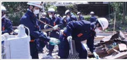
震災後、倒壊家屋のがれき撤去作業を行う消防団員
