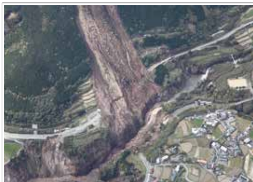
阿蘇大橋付近の被害状況 (熊本県阿蘇郡南阿蘇村)
