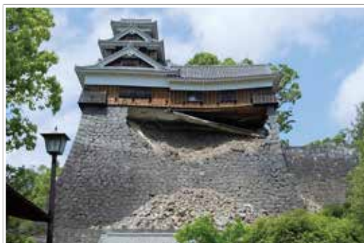
熊本城の被害状況 (熊本県熊本市)
