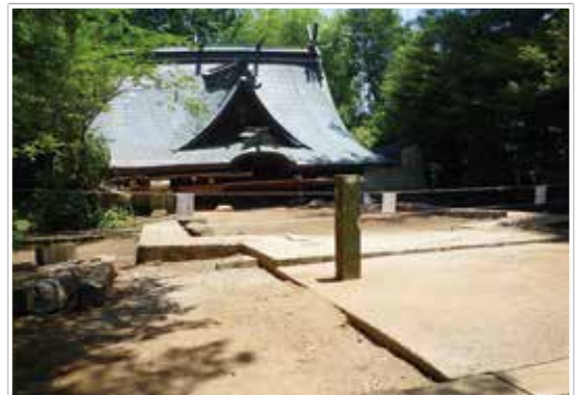
倒壊した寺社
