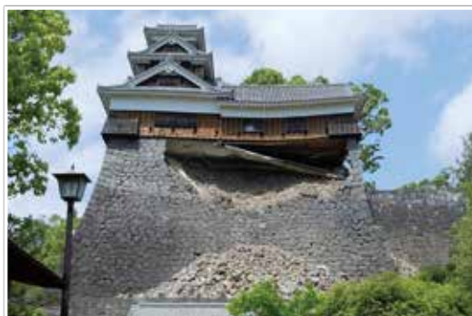
熊本城の被害状況 (熊本県熊本市)
