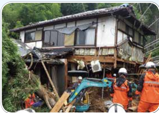
6月20日からの梅雨前線に伴う大雨での住家被害(熊本市北区)
