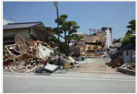
多くの建物が被害を受けました
