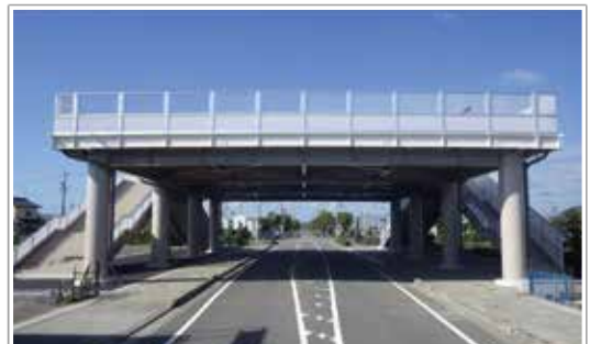
写真-3 津波避難タワー
