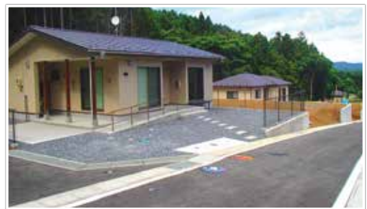
建設が進む災害公営住宅（宮城県女川町）
