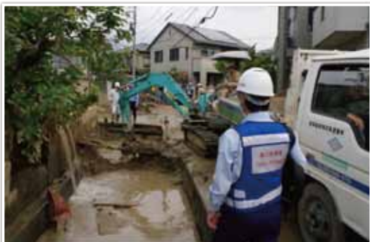
土砂撤去の支援（H26広島土砂災害）
