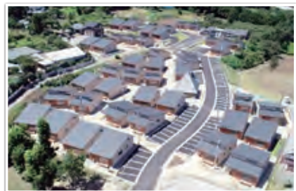
半年の工期で建設した地元工務店による買取り型災害公営住宅
