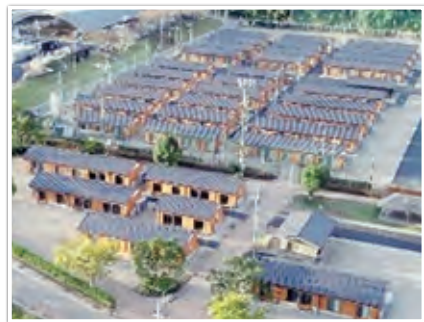
球磨村で整備した木造仮設住宅(瓦屋根を初めて採用)
